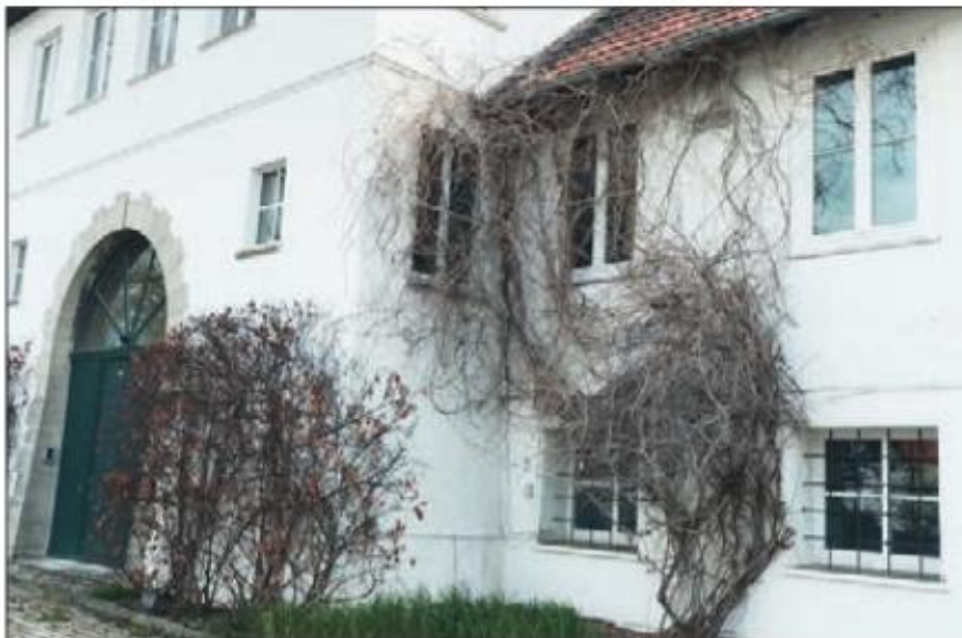
Das alte Gutshaus in Wendessen.
