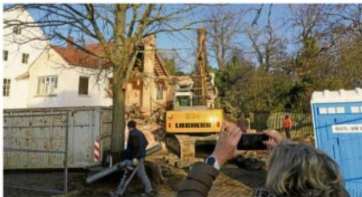
Die Hospizvereinsvorsitzende Dagmar Ammon fotografierte den Beginn der Bauarbeiten am Gutshaus Wendessen.
