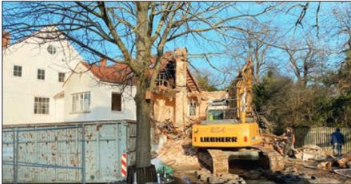
Stück für Stück wird der Gebäudeteil neben dem Haupthaus „zerlegt“. Fotos: privat
