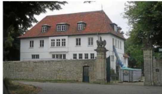
Derzeit wird das Gutshaus in Wendessen entkernt, ehe danach der Innenausbau des geplanten Wolfenbütteler HospizZentrums beginnen kann.
