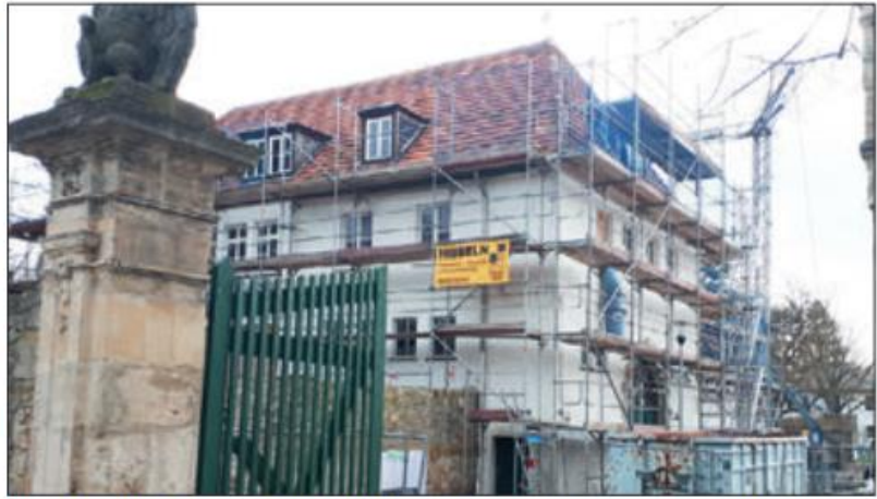
Das Gebäude wurde vor kurzem eingerüstet.
