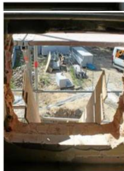
Ein Blick ins Freie – dort entsteht einer der Eingänge. KATHARINA KELLER
