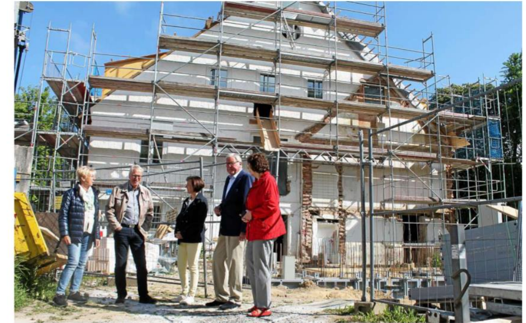
Wie läuft es auf der Baustelle? Ein Besuch im und am Gutshaus, das ein Hospiz wird.
