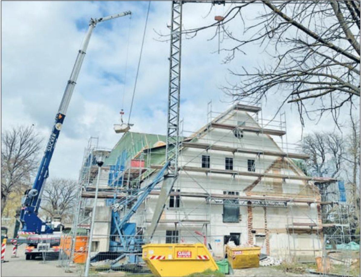
Was breit aufgestelltes Bürger-Engagement zuwege bringt: Am HospizZentrum kann im Juli Richtfest gefeiert werden! Foto: privat
