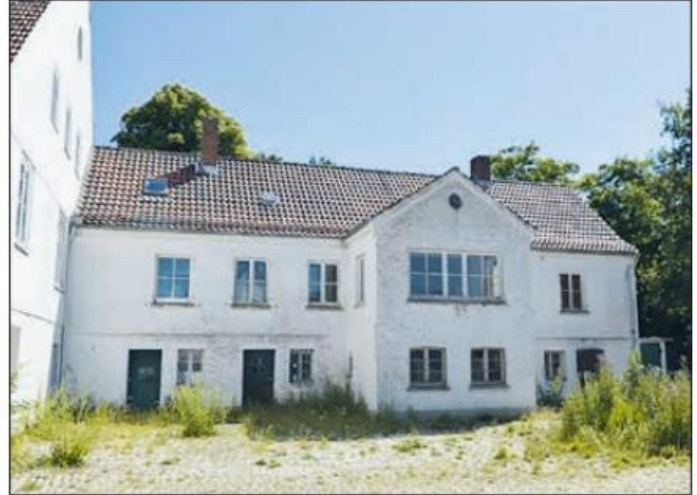
Ein Rückblick ins Jahr 2020: Dieser Gebäudeteil war nicht zu retten. An seiner Stelle ist ein Anbau, bestehend aus Treppenhaus und Bettenaufzug, errichtet worden. Hier wird auch der neue Haupteingang sein. Foto: Hospizverein
